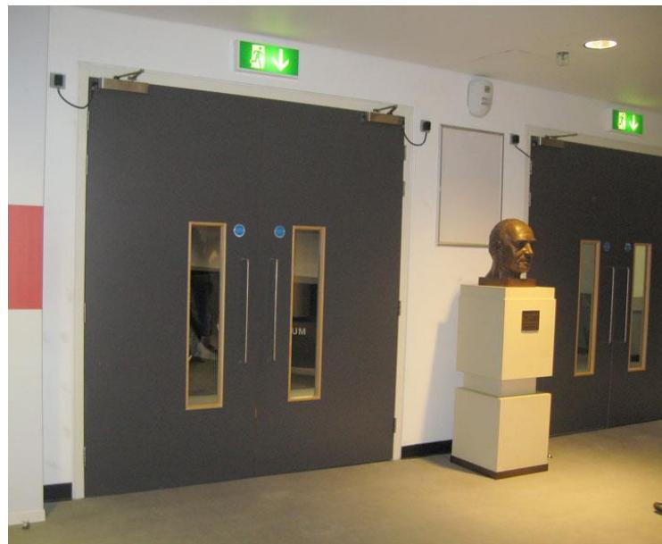
Рисунок А.5 - Прозрачные вставки на дверях (Стадион Уэмбли, Великобритания)
