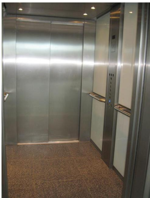
Рисунок А.7 - Кабина лифта с двусторонним открыванием дверей
