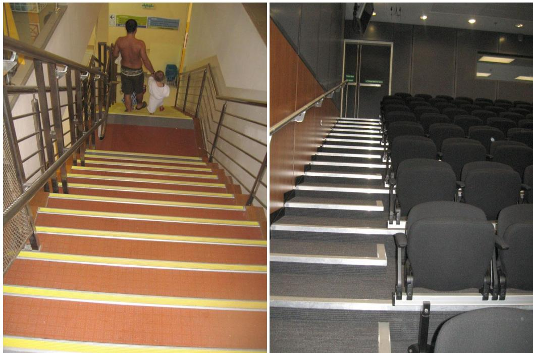
Рисунок А.4 – Примеры маркировки края ступеней лестниц
