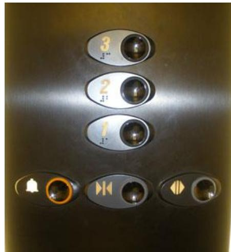
Рисунок А.8 - Кнопки оборудованы тактильной индикацией
