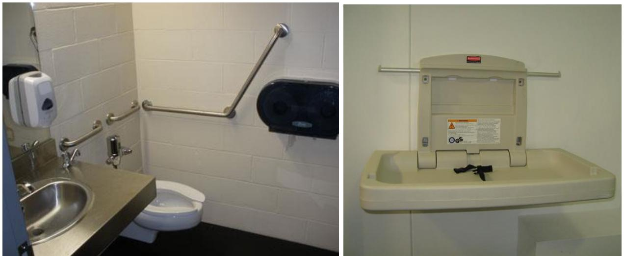
Рисунок А.9 - Пример оборудования доступного туалета
