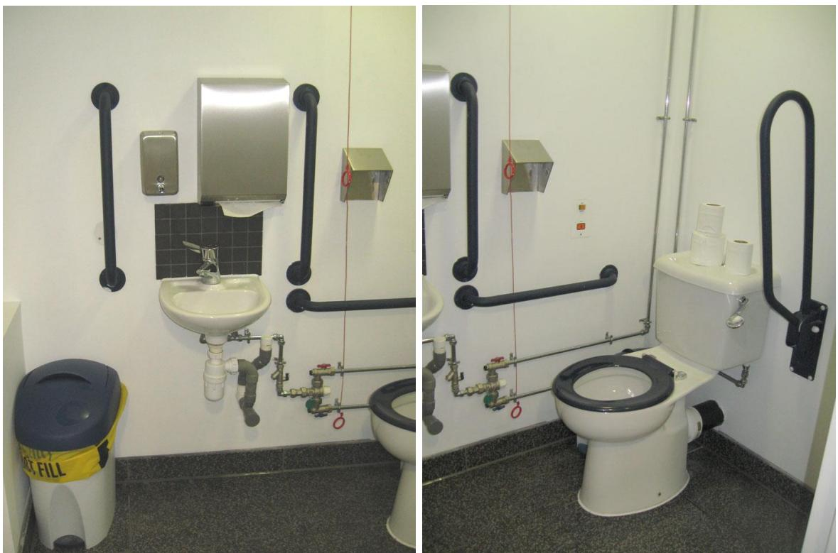
Рисунок А.10 - Пример оборудования доступного туалета
