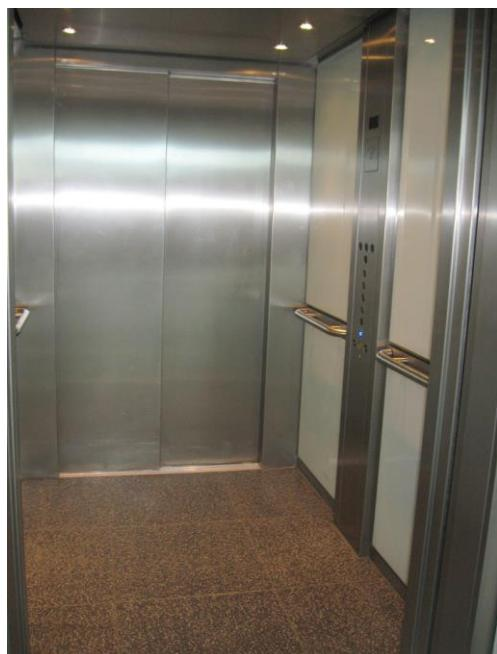
Рисунок А.7 - Кабина лифта с двусторонним открыванием дверей
