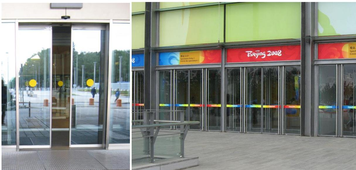
Рисунок А.6 - Примеры маркировки стеклянных дверей
