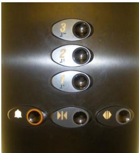
Рисунок А.8 - Кнопки оборудованы тактильной индикацией
