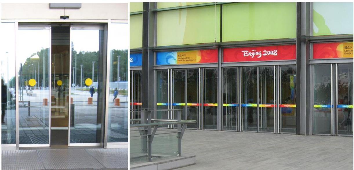
Рисунок А.6 - Примеры маркировки стеклянных дверей
