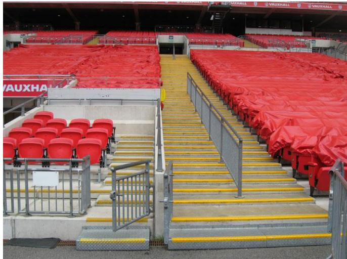
Рисунок А.17 - Оборудование лестниц центральными поручнями
